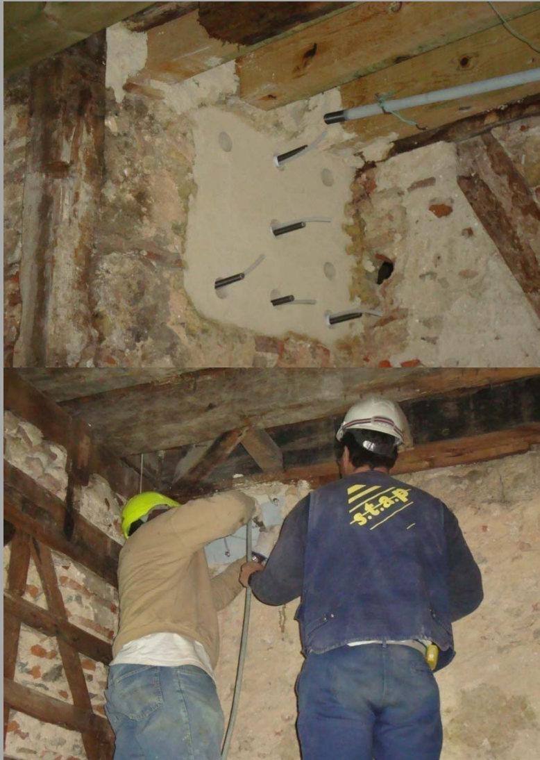
Ancoragem interior com manga injectada
