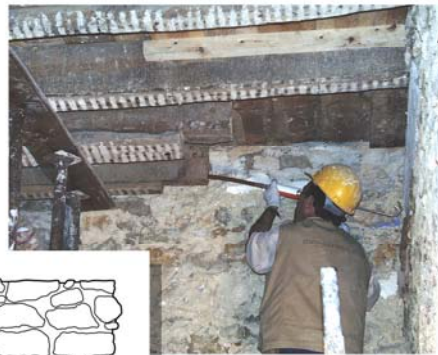
Reparação de secções degradadas de vigas de madeira de um pavimento utilizando produtos poliméricos e FRP. Execução em obra.c
