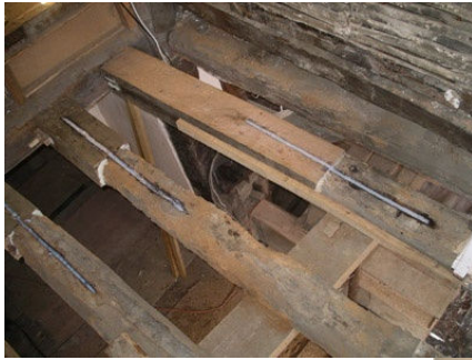
Vista superior das vigas reparadas.
