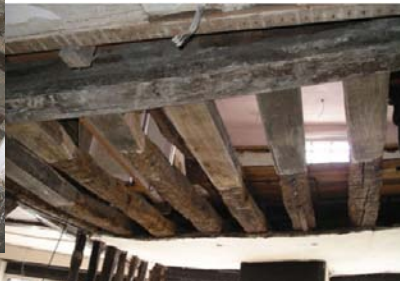
Vista inferior das vigas reparadas.
