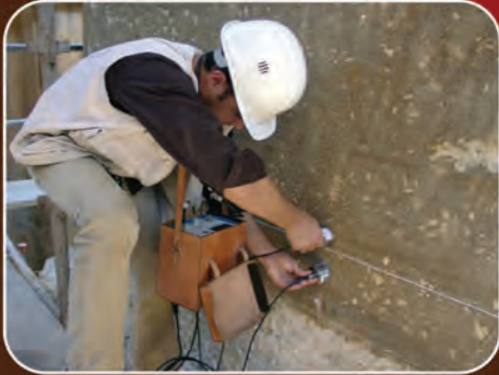
Ensaio de ultra-sons na Ponte Angeja
