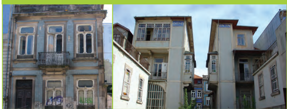
2 - Edifício B – Fachada Norte; Edifício A e B – Fachada Sul.
