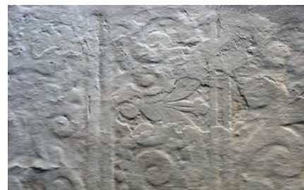
Fig. 6 - Convento de S. Francisco, Almodôvar
