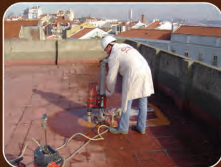
Extracção de carote na laje de cobertura de um edifício, para caracterização do material
