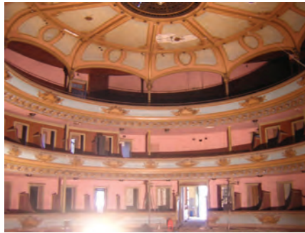
Aspecto geral da sala antes da intervenção
