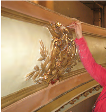
Aspecto da reintegração cromática das superfícies: sem velaturas e patinaturas (lateral esquerda à cartela) e o aspecto final após velaturas e patinaturas (lateral direita à cartela)
