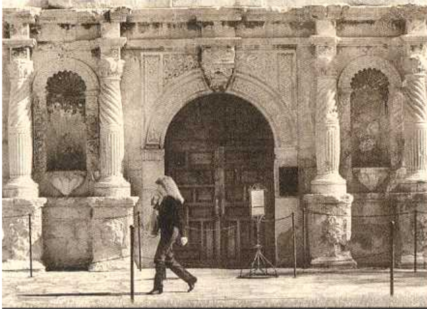
Entrada principal do Forte Álamico, exibindo sinais evidentes de erosão da pedra, devido a humidade ascendente
