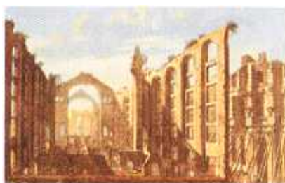
Fig. 7 - Ruínas da Casa da Ópera. Notem-se os escoramentos do lado direito
