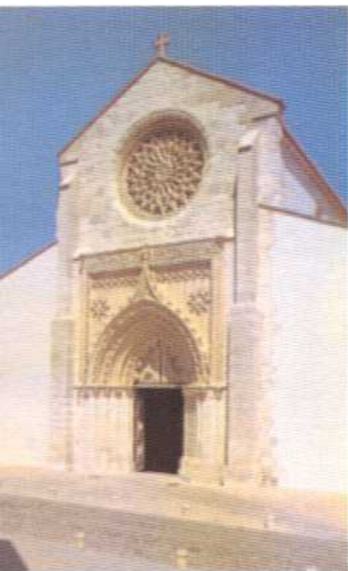
Igreja de Nossa Senhora da Graça antes e após as obras de restauro Freguesia de Marvila
