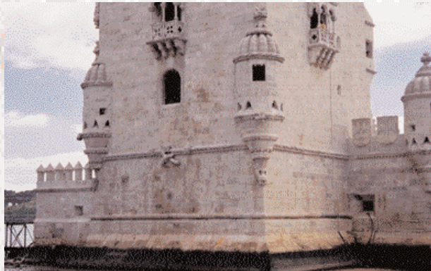
A Torre de Belém, após a intervenção de 1994-98. Pormenor.
