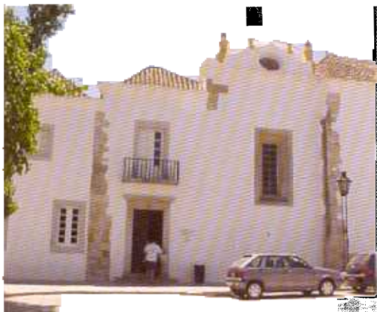
Entrada do Convento de Faro.
