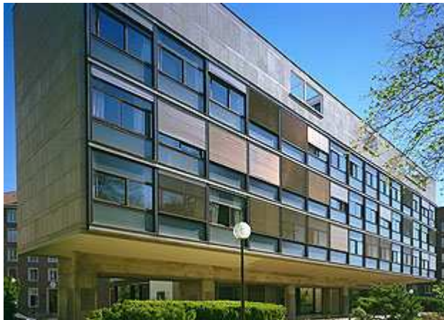
Pavillon de la Suisse, Cliché Daniel Lebéé, SDIG © Fondation Le Corbusier.
