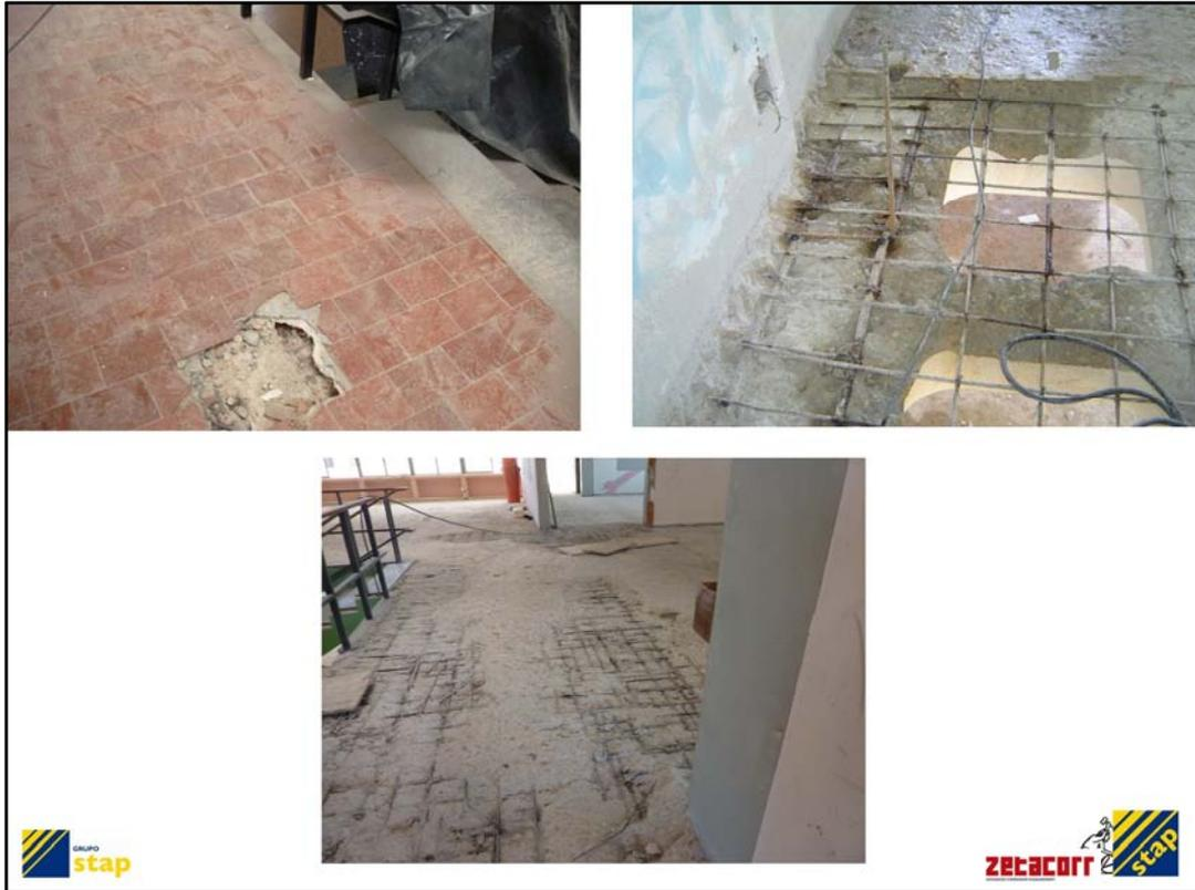
Caso de um tratamento eletroquímico de uma estrutura de betão armado.
