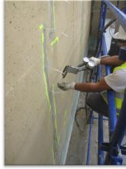
Trabalhos preparatórios. Injeção de fissuras estruturais com resina de epóxico.
