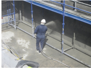
Projeção da 2ª camada de matriz cimentícia
