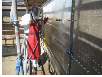
Preparação das superfícies a reforçar – hidrodcapeagem.
